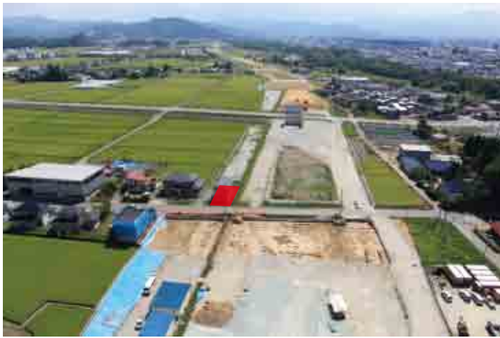
写真1 第6次調査区周辺の状況（赤色部分）
