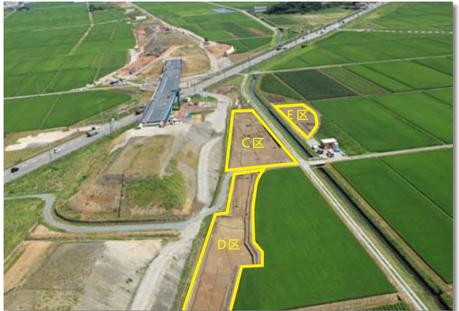
現在建設中の高速道路本線の右側にあるのが調査区、手前がD区、農道を挟んだ上がC区、水路を挟んでその右側がE区です。発掘調査に並行し、国道7号にちょうど橋脚の架かった時期でした。
