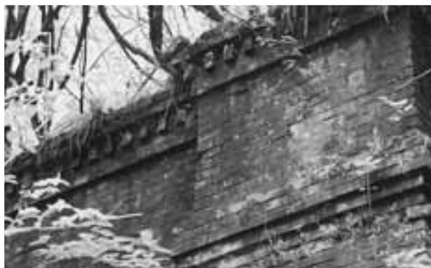
写真図版 14 猿羽根第三隧道 笠石部歯飾り (分類 (A))
