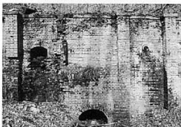
写真12 第七號隧道 横坑(外部)(02年12月)
