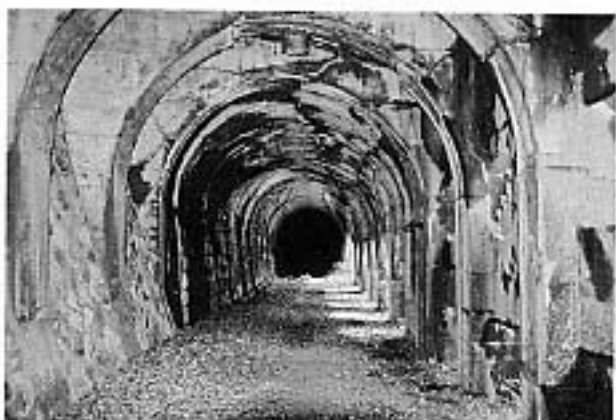
写真20 第十一號隧道 青森方坑門延伸部（02年10月）
