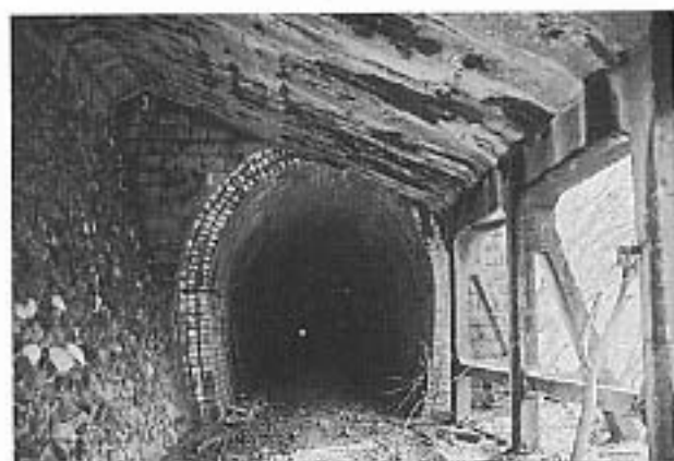
写真25 第十三号隧道 青森方坑門と延伸部 (03年11月)
