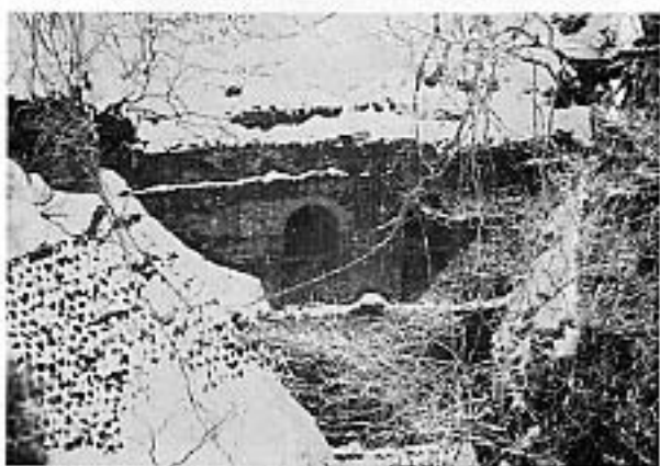
写真14 第四號隧道 横坑(03年3月)
