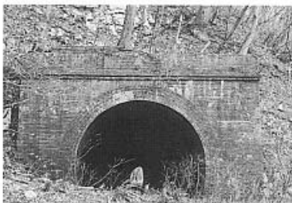
写真5 第六號隧道（初代）青森方（02年12月）
