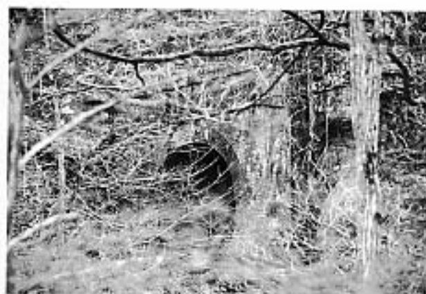
写真18 第六號隧道（二代）福島方（02年12月）
