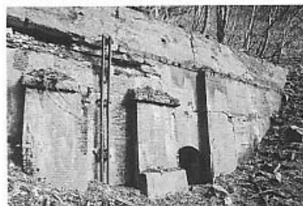
写真27 第十三号隧道 横坑 (外部) (03年11月)
