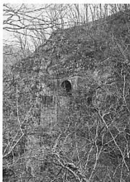
写真2 第五號隧道（初代）青森方（02年12月）
