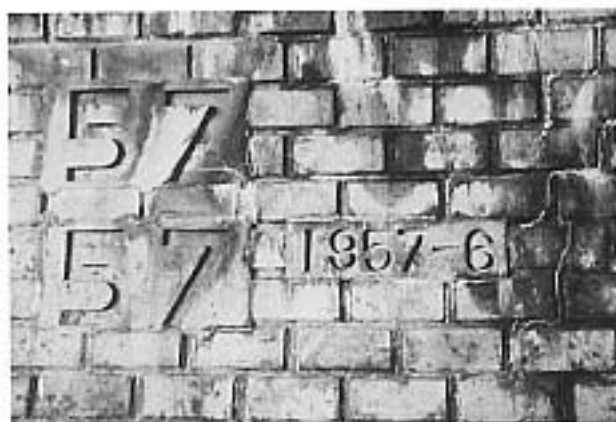
写真26 第十三号隧道 大規模な改修箇所 (02年10月)
