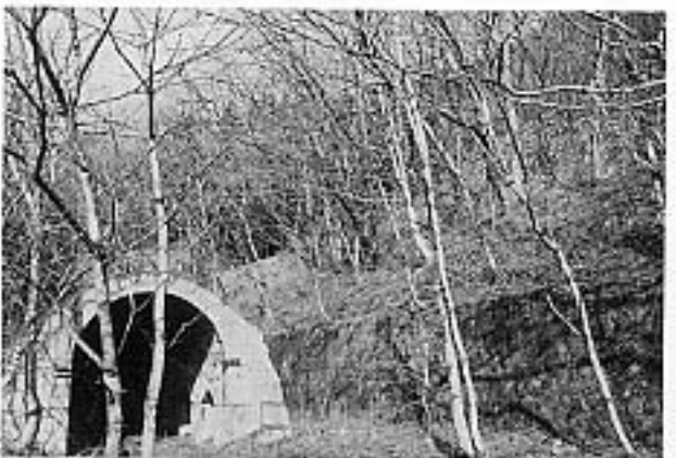
写真23 第十三號隧道 福島方坑門延伸部（03年11月）
