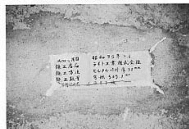
写真32 第十四号隧道 アーチ部補修時の銘板 (03年4月)
