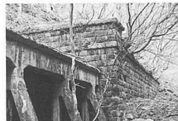
写真31 第十四号隧道 青森方坑門と延伸部 (03年4月)
