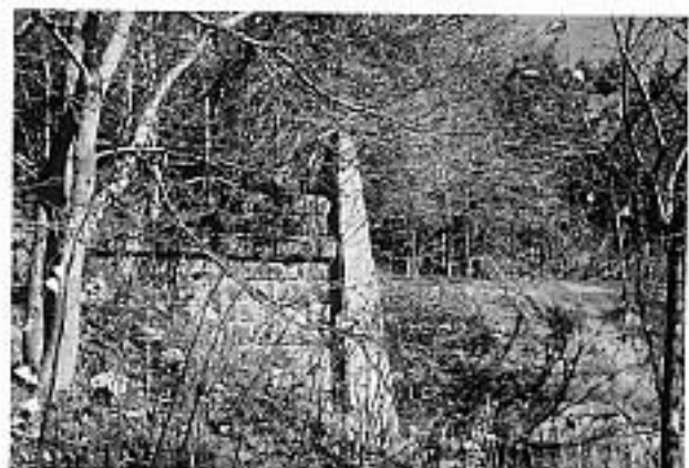
写真19 第十一號隧道 福島方坑門（03年11月）
