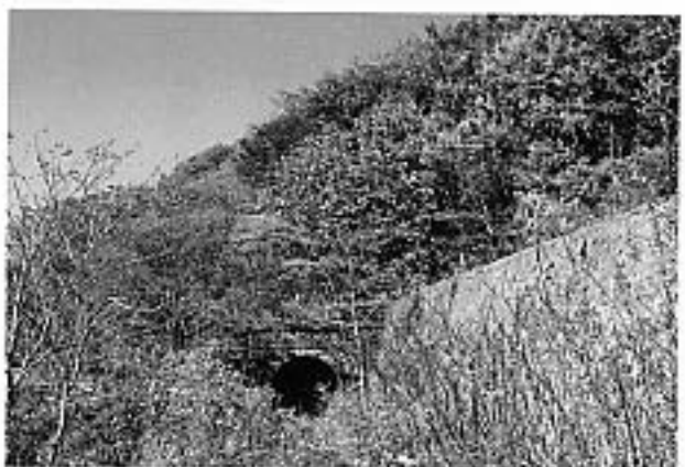
写真21 第十二號隧道 福島方坑内（02年10月）
