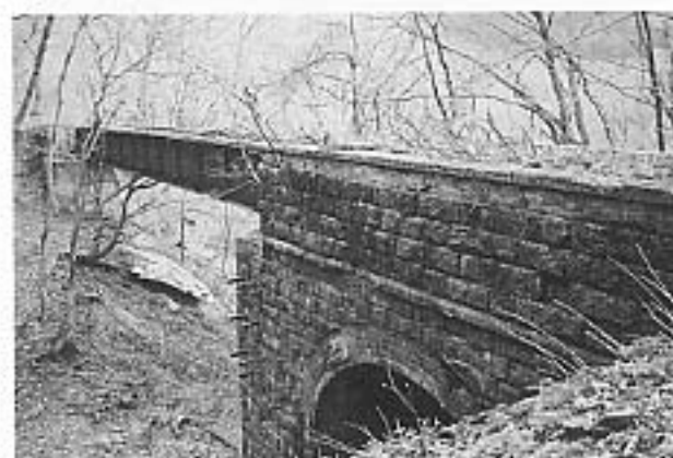
写真28 戸澤橋梁 橋台とアーチ (03年4月)
