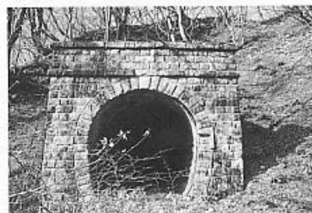
写真30 第十四号隧道 福島方坑門 (03年11月)
