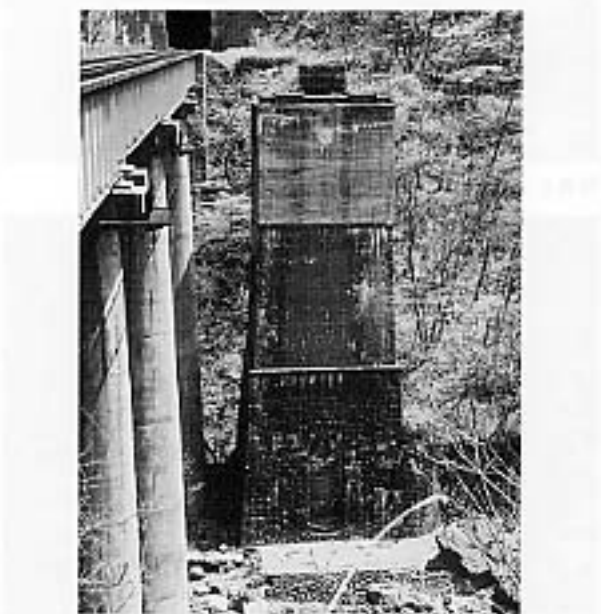
写真16 松川橋梁(二代)橋脚(03年5月)
