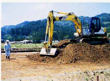
調査区が決まったら遺跡の表面を覆う土を取り去ります。主に重機械を用いて行います。
