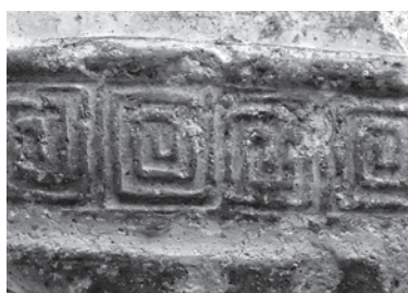
1 突帯貼り付け部
