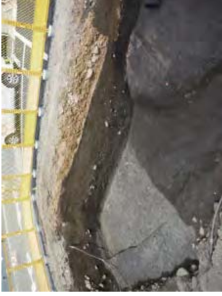
写真2 三の丸堀跡 SD1401(南東から)
