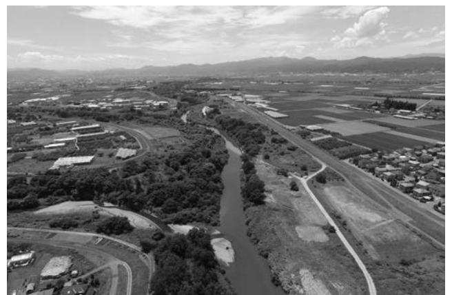
写真25 調査区空撮（中央を流れるのが須川）（北から）
