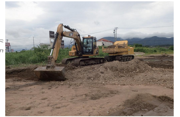
写真1 1区表土除去作業(西から)
