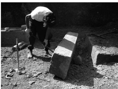
写真 25 石作り工程㉖・向き変え
