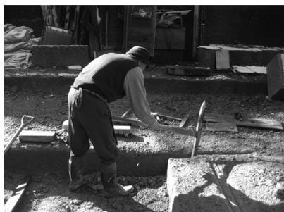
写真8 溝掘り工程⑩・溝掘り (小口)
