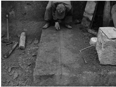
写真 27 溝掘り工程①・線引き
