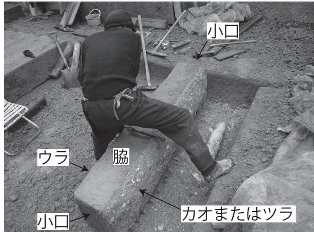
写真2 高畠石の面の呼び方
