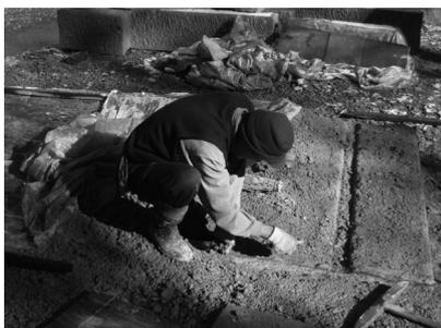
写真7 溝掘り工程⑦・線引き (小口)
