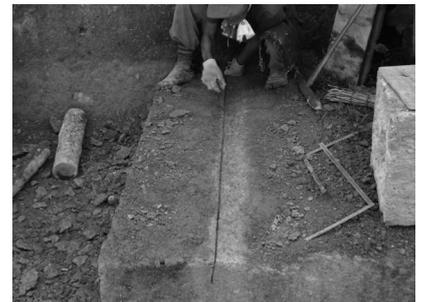
写真 32 溝掘り工程③・線引き
