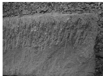
写真 83 ツル削りで脇に残る痕跡
