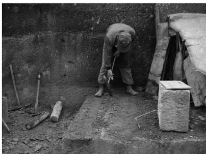
写真4 溝掘り工程②・溝ツキ
