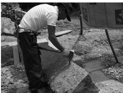
写真 22 石作り工程㉓・サシバ割り
