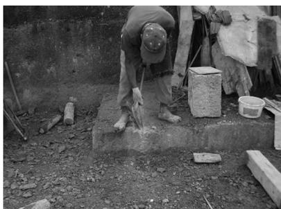
写真9 溝掘り工程⑪・角立て
