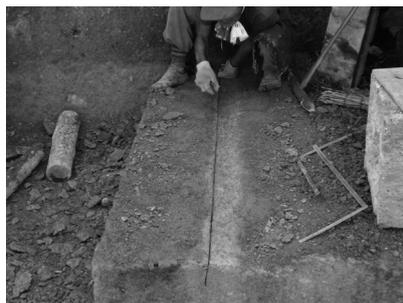
写真5 溝掘り工程③・線引き
