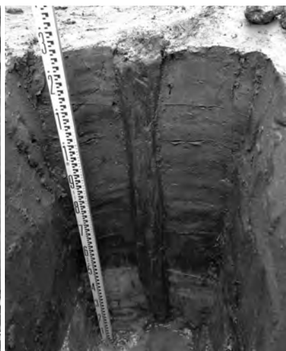
写真4 打ち込まれた杭（柱）, 東から
