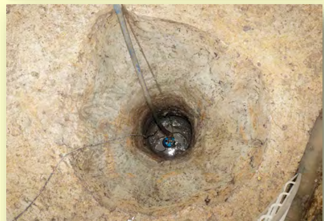
素掘り井戸の完掘状況(深さ3m) 最下層は帯水層(砂層)であり、湧水がありました。
