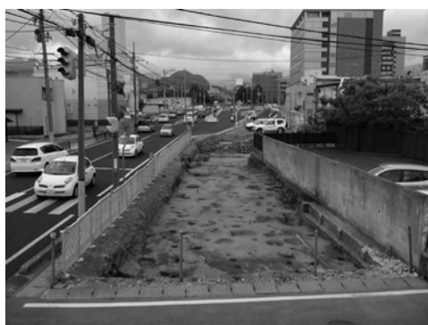
1区完掘状況 (西から)
