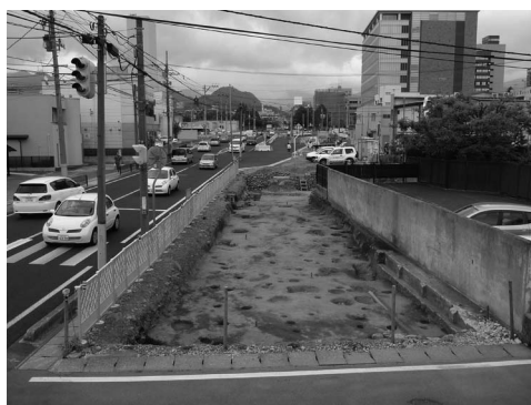
1区完掘状況 (西から)
