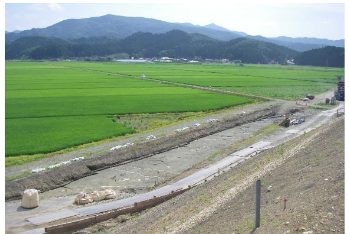
C区遺構検出状況(北から)
