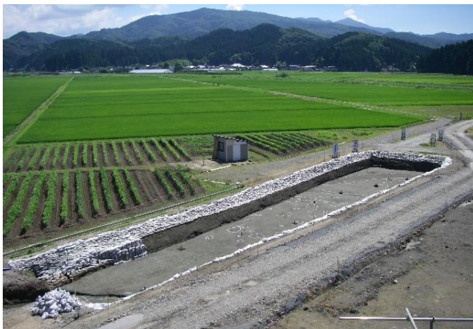
A区遺構検出状況(北から)
