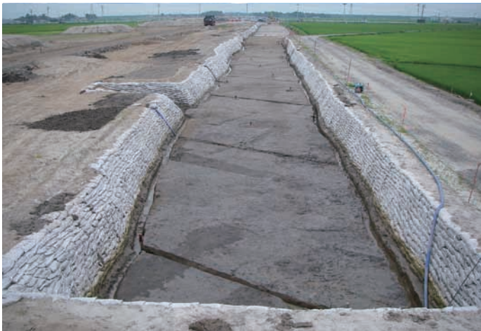
F区全景(東から)
