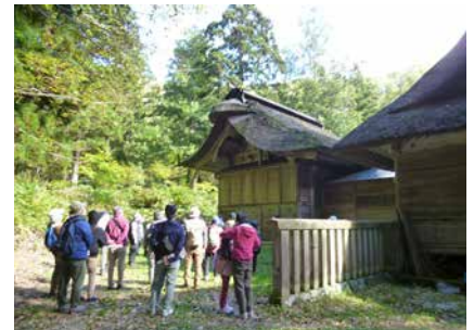
安久津八幡神社・本殿
