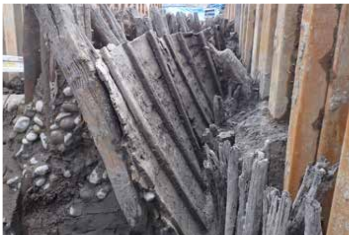
土橋の杭列・板材（北から：右側の玉石・盛土は除去）
