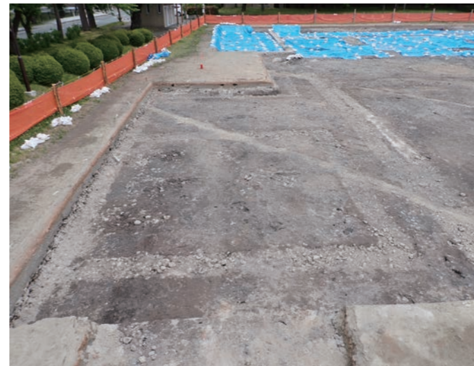
写真1 3区第1面遺構検出状況(南から)
