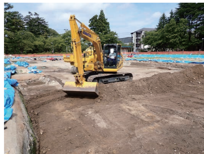
写真1 3区第2面の掘り下げ状況(東から)
