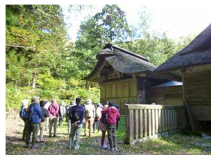
安久津八幡神社・本殿
