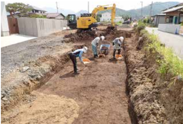
写真1 重機稼働、遺構検出状況
