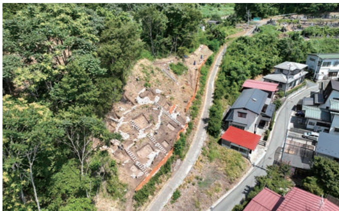
斜面地の調査の様子（南西から）
