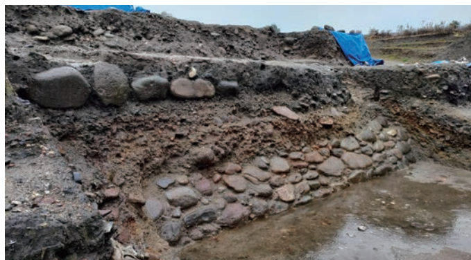
本丸東土塁裾部の護岸石垣(南東から)
