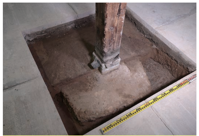
3号棟独立柱の礎石とコンクリートによる補強
